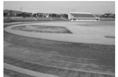
現存のスポーツ施設の修繕や改修の要望も多い
